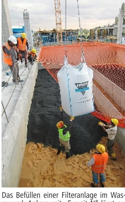
Das Befüllen einer Filteranlage im Wasserwerk Ankara mit „Everzit N“ lässt erahnen, welche Mengen an Filtermaterial für eine Großanlage gebraucht werden.
