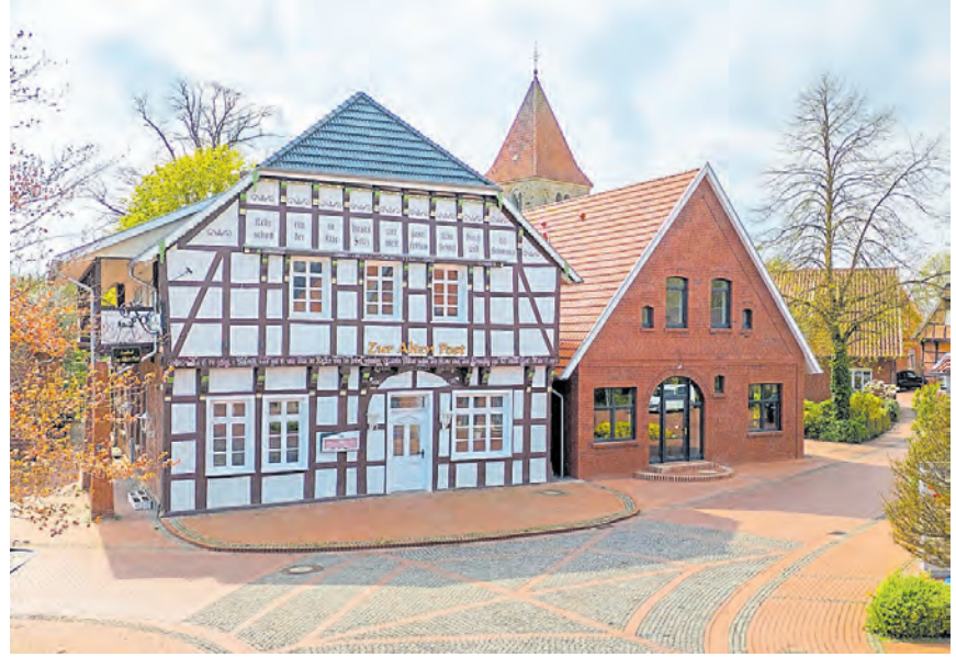
Dank der aufwendigen Renovierung und Modernisierung durch die Familie Kock erstrahlt die „Gaststätte zur Alten Post“ nun in neuem Glanz.
